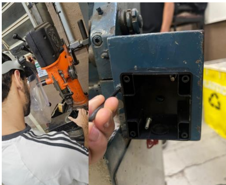
Figura 33: Fixando a caixa do botão de emergência.
