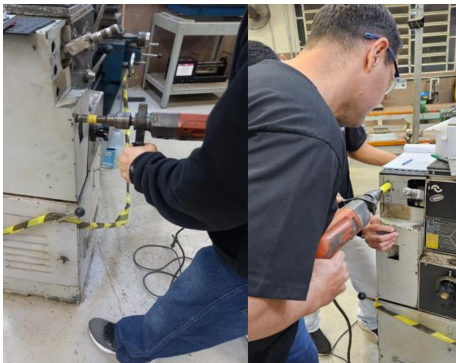
Figura 20: Furação dos pontos dos sinaleiros.
