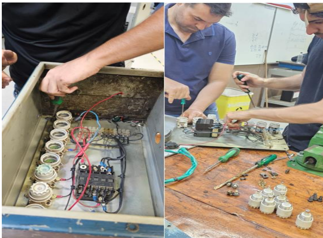
Figura 16: Desmontando o painel 2. FONTE: Próprio autor (2025).
