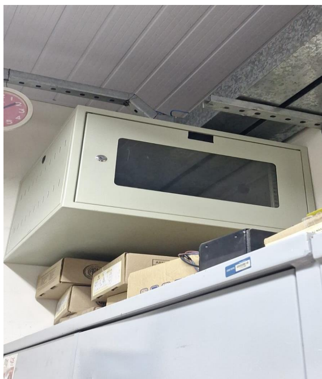
Figura 12: Fixação do rack FONTE: Do Próprio Autor, 2025
