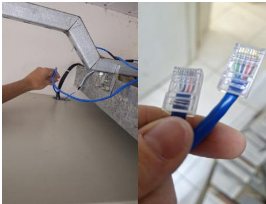
Figura 13: Implantação do cabo de rede UTP
