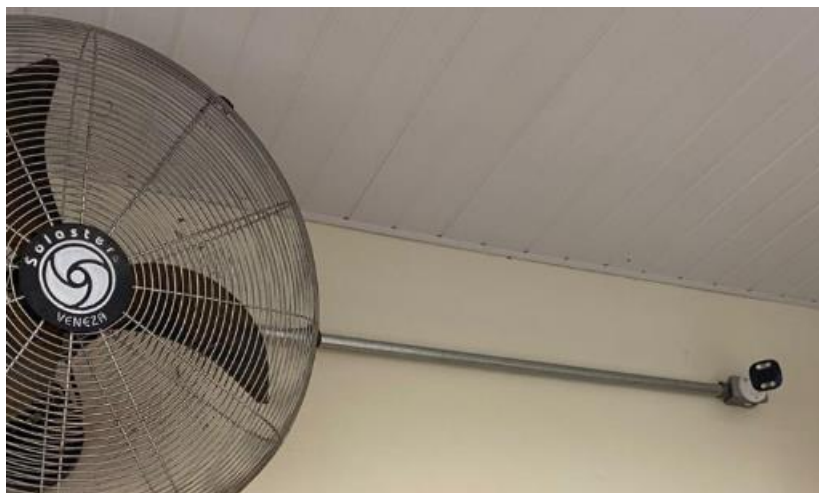
Figura 20 Fixação da nova infraestrutura FONTE: Do Próprio Autor, 2025
