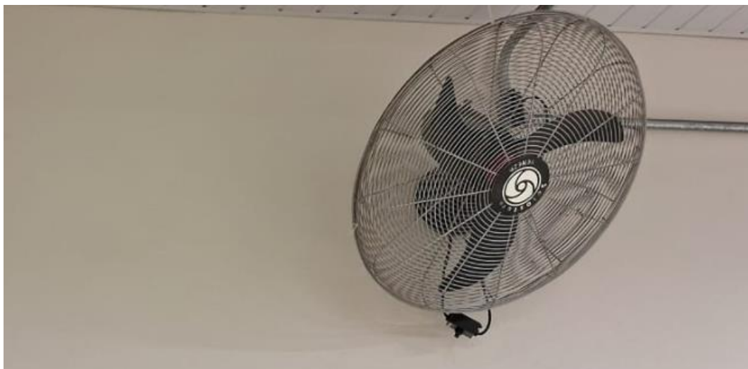
Figura 16: verificação da infraestrutura existente FONTE: Do Próprio Autor, 2025
