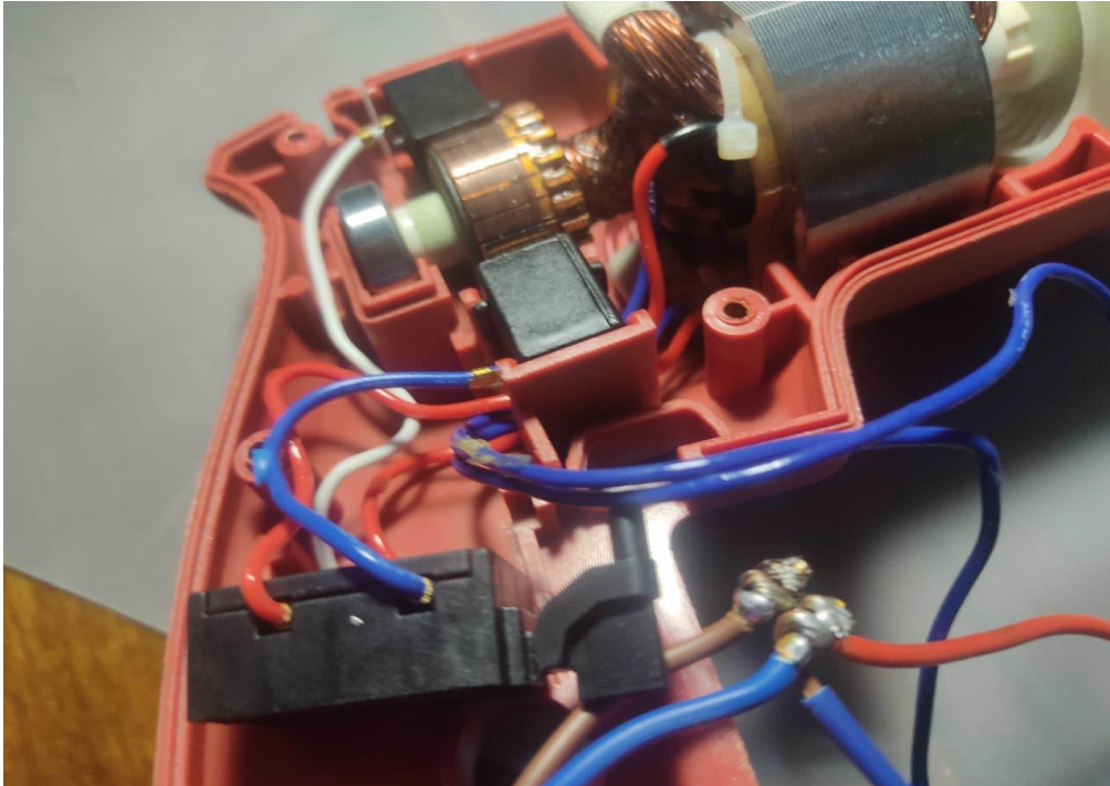
Figura 27 – Condutores Elétricos da Furadeira
