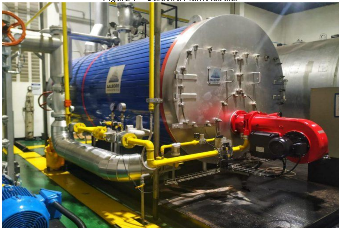
Figura 7 - Caldeira Flamotubular
