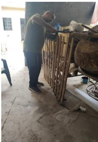
Figura 18: Fixação dos vasos e do painel fotovoltaico
