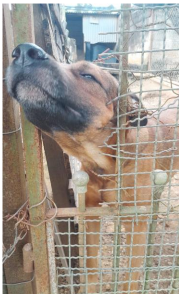
Figura 1 - Portão danificado de um dos canis Fonte: acervo do grupo (2025)
