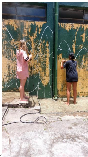
Figura 16: Limpeza com a vap para retirar a antiga pintura Fonte: acervo do grupo (2025)
