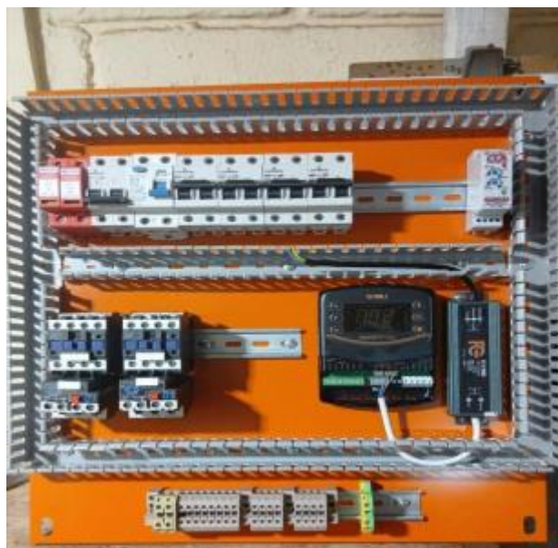
Figura 5. Montagem dos componentes no painel
