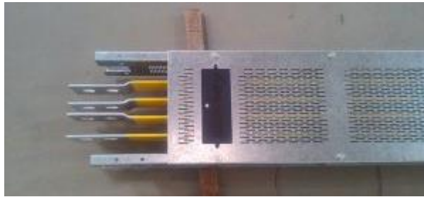
Figura 18 - Bus-way trecho reto. Fonte: Flexmaster barramentos blindados.
