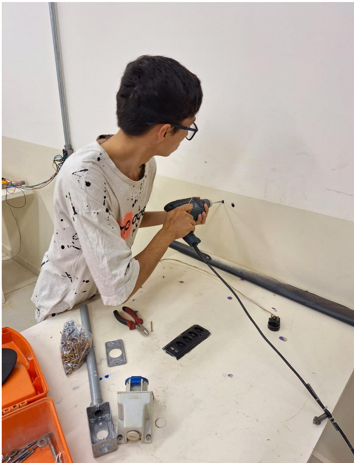
Figura 22: Montagem de Infraestrutura FONTE: Próprio Autor (2025)
