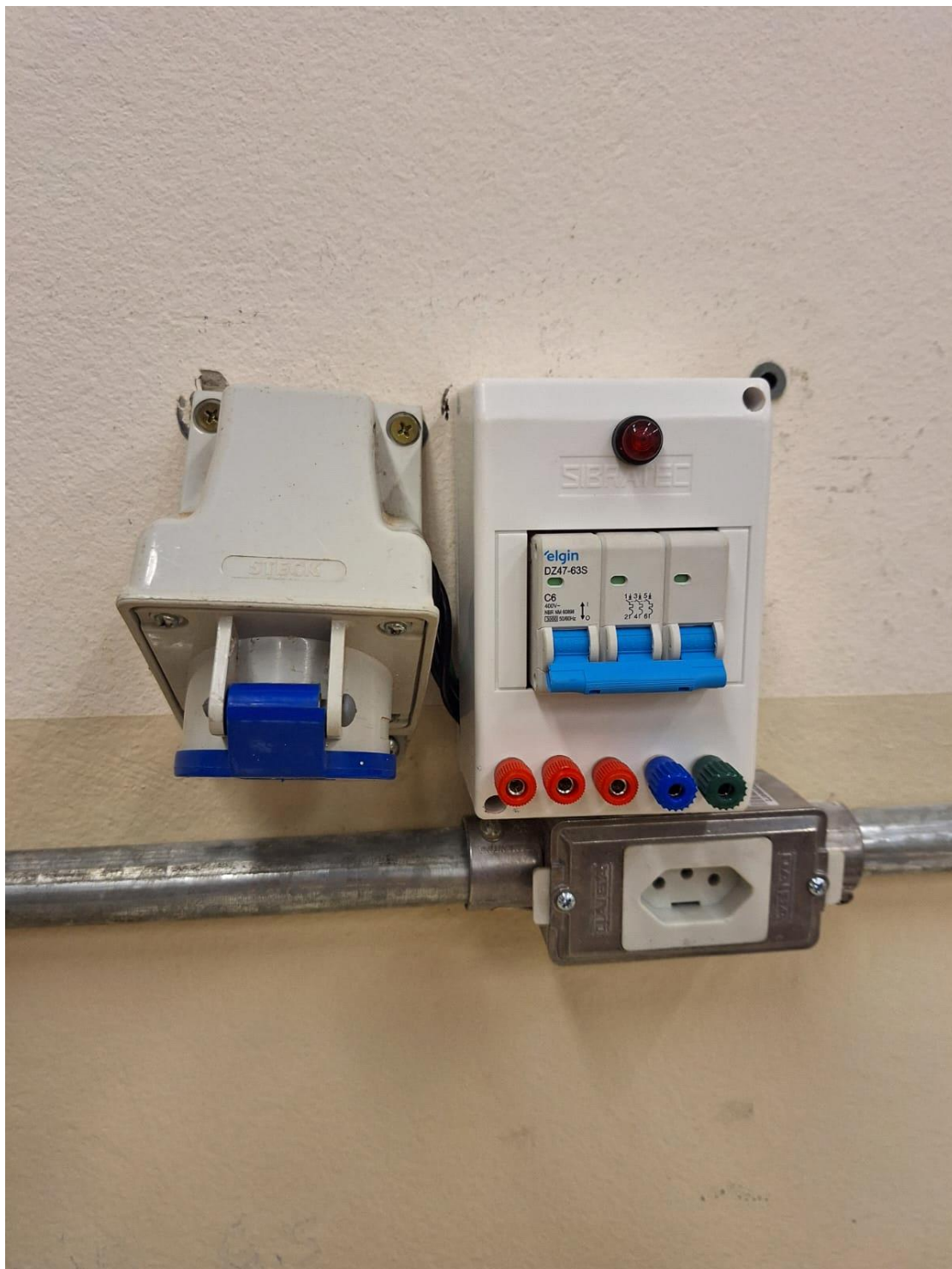
Figura 31: Resultado Final das adequações elétricas FONTE: Próprio Autor. (2025)
