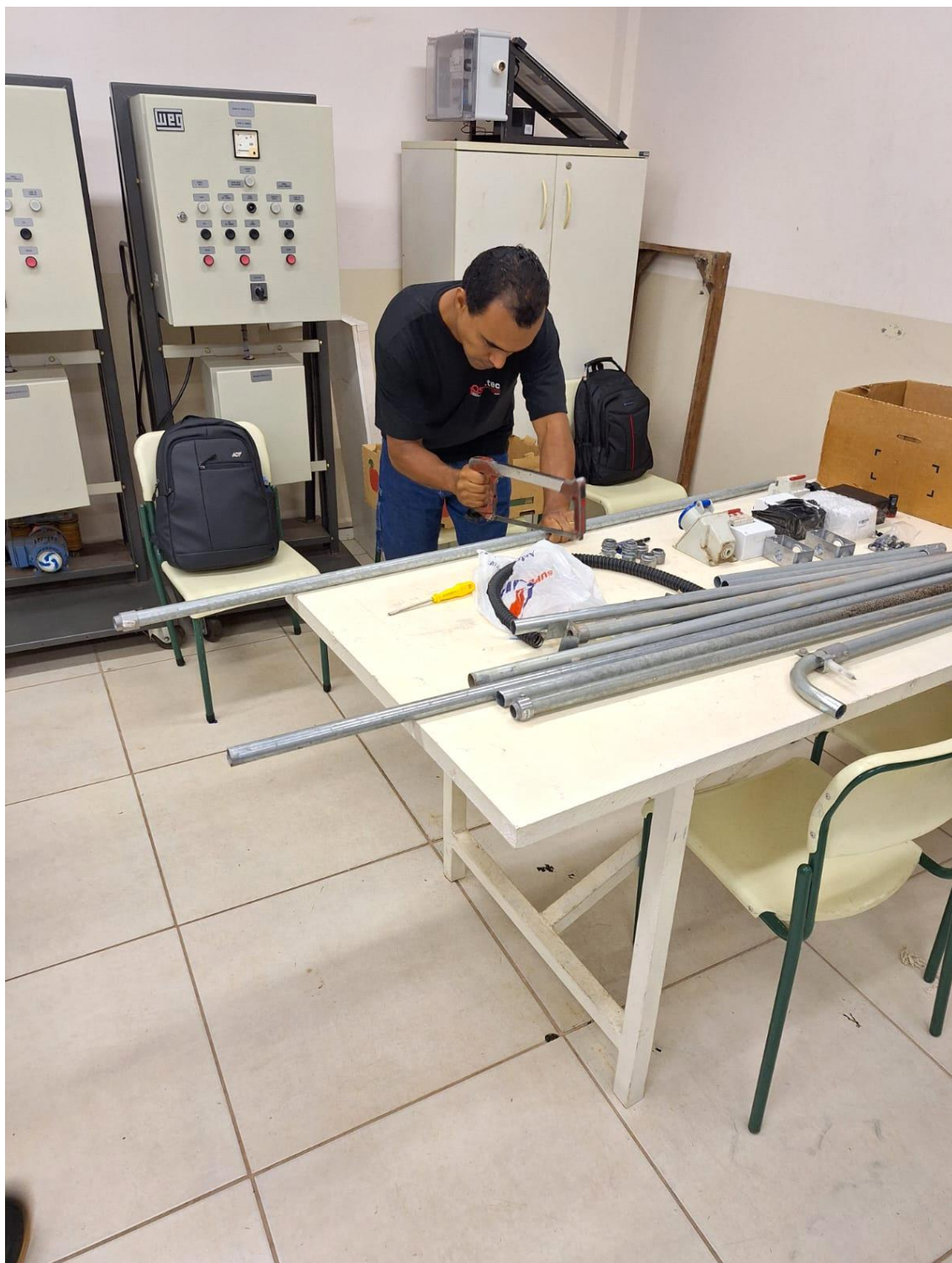
Figura 20: Montagem de Infraestrutura. FONTE: Próprio Autor (2025)
