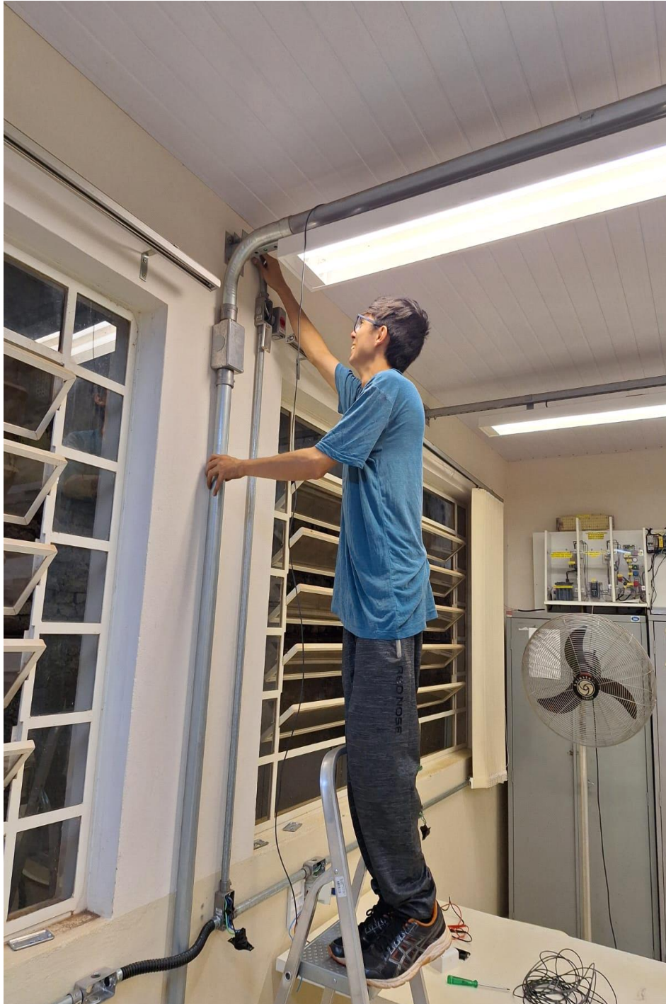
Figura 24: Passagem dos cabos pelos eletrodutos. FONTE: Próprio Autor (2025)
