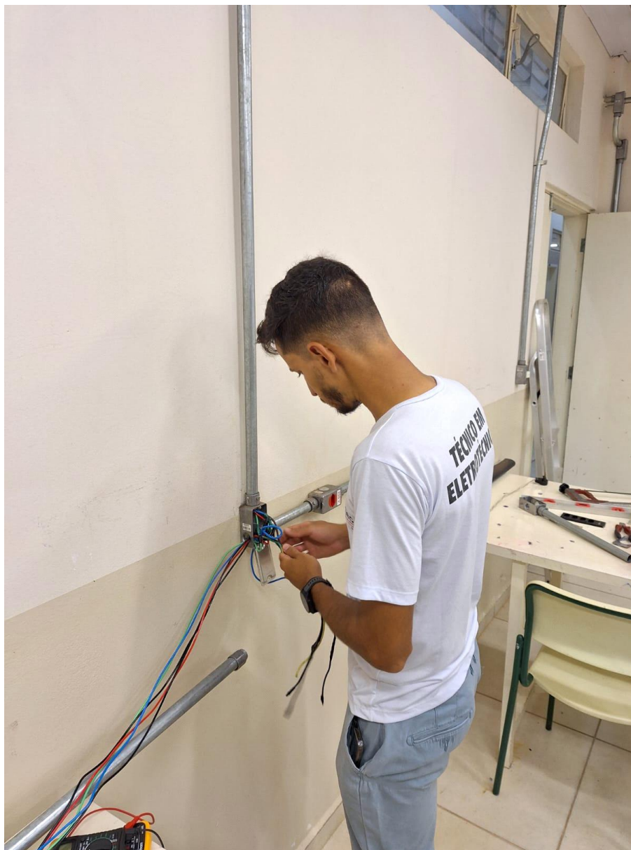
Figura 25: Passagem dos cabos pelos eletrodutos. Fonte: Próprio Autor (2025)
