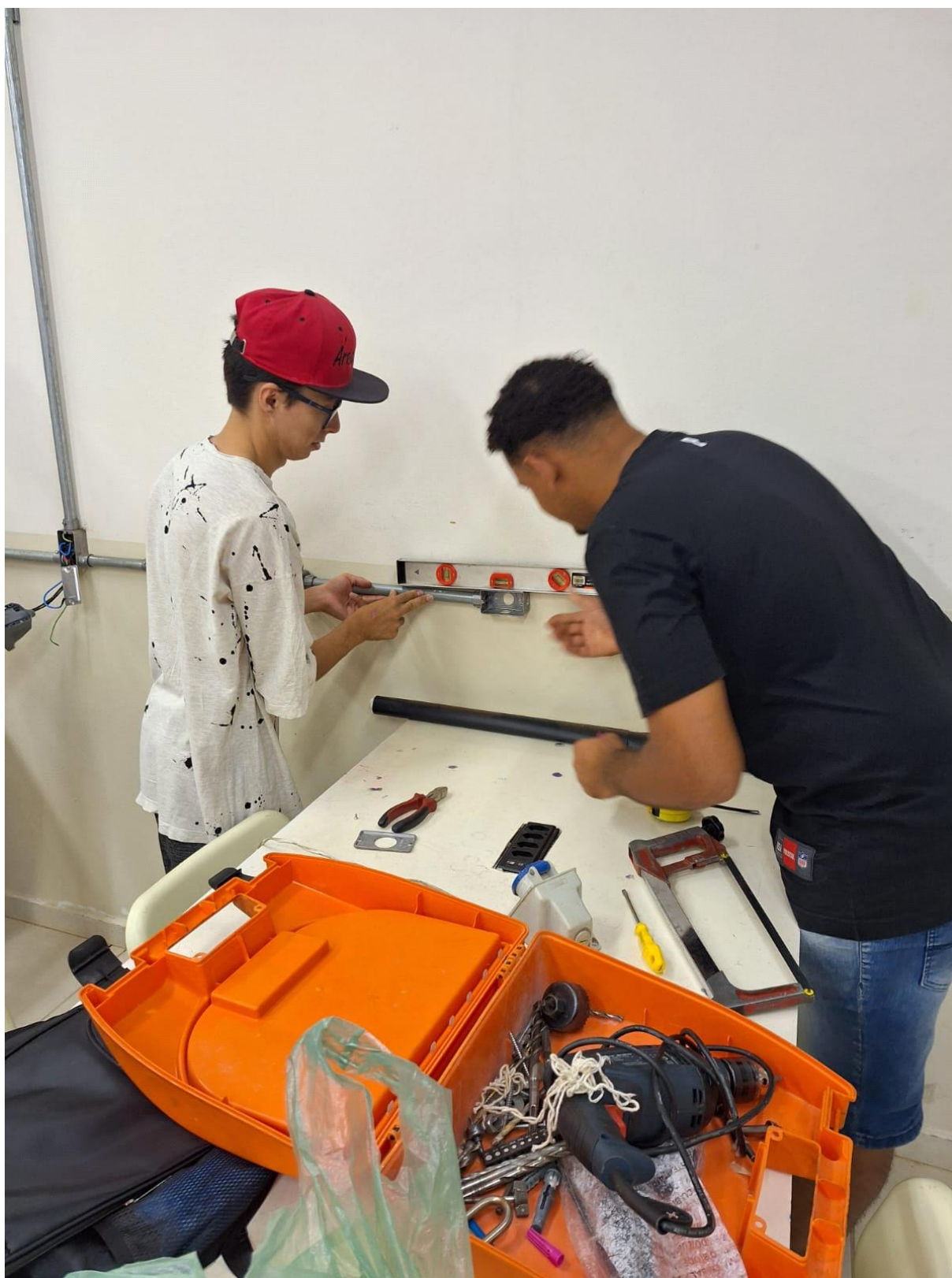
Figura 21: Montagem de Infraestrutura FONTE: Próprio Autor (2025)
