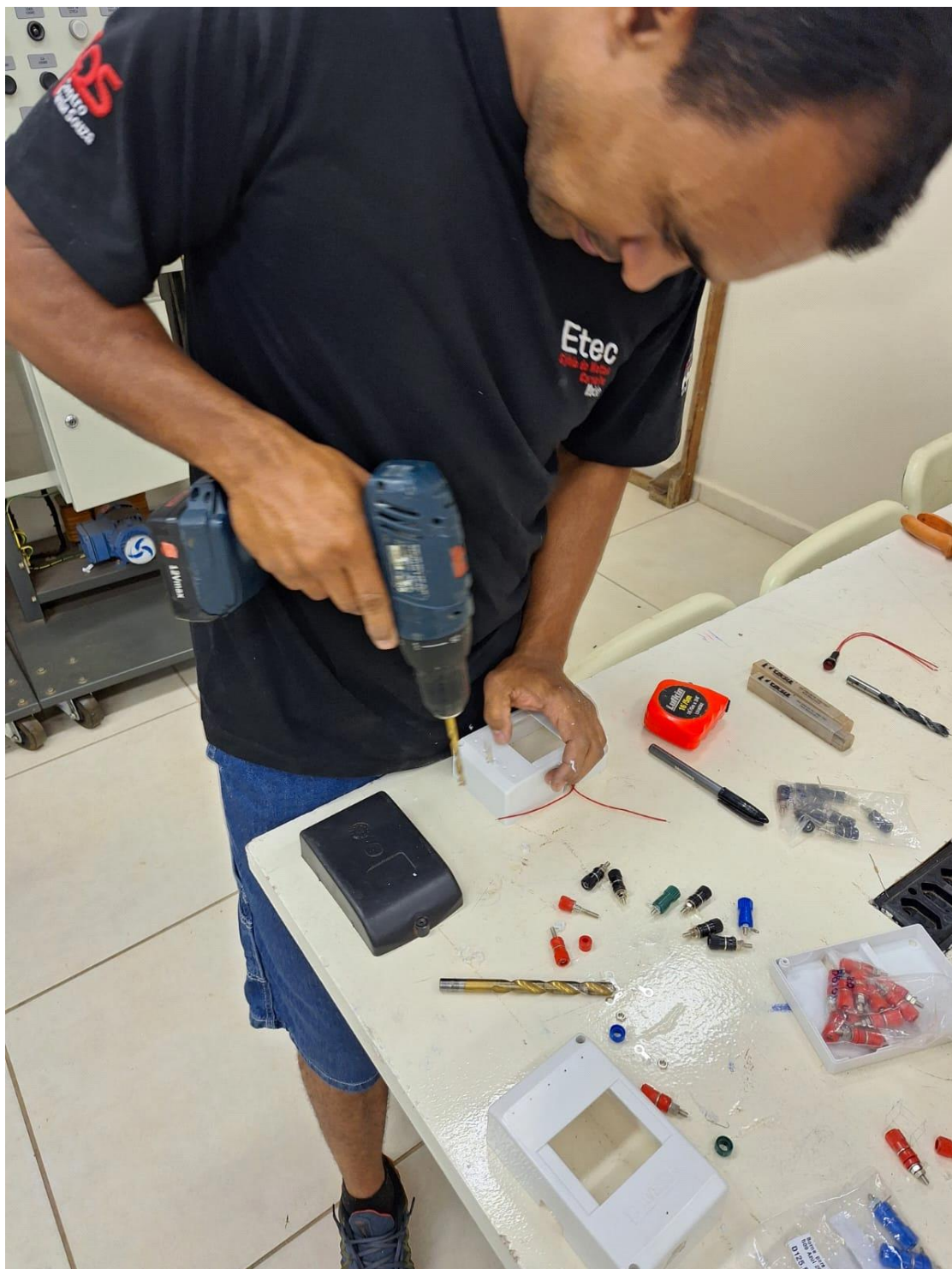
Figura 27: Realizando furação para instalação de borne tipo banana. Fonte: Próprio Autor (2025)
