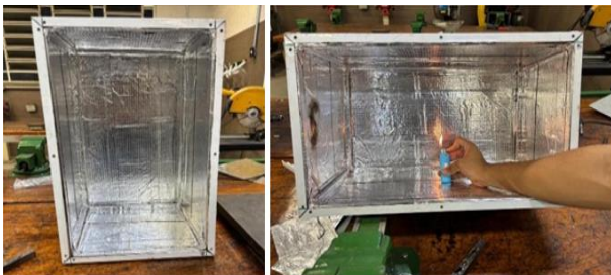
FIGURA 27 – Instalação da malha térmica FONTE: Do próprio autor, 2025
