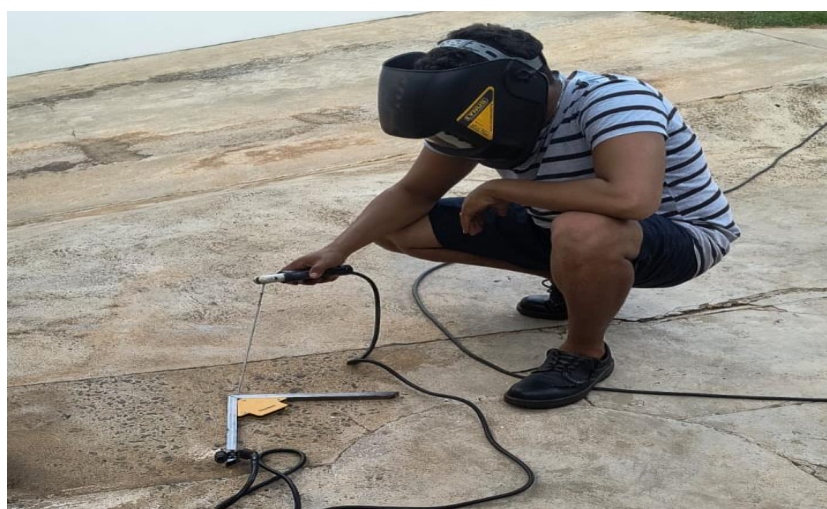
FIGURA 22 – Soldagem das barras de metalon FONTE: Do próprio autor, 2025
