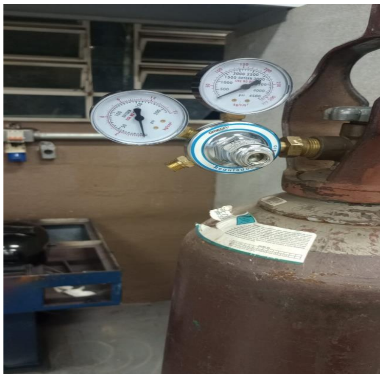
Figura 19: Instalação de um manômetro novo FONTE: Do próprio Autor, 2025
