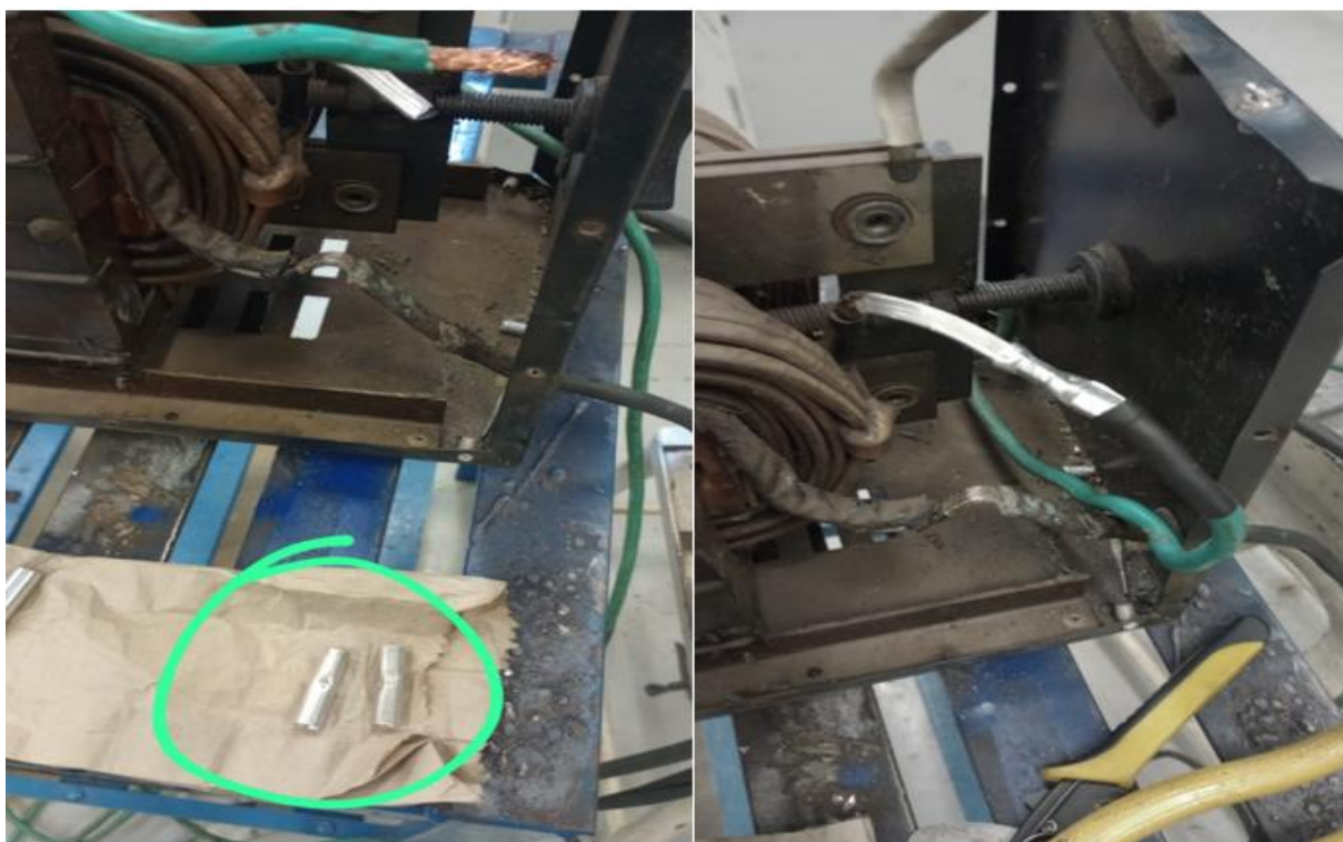
Figura 35: Crimpagem dos terminais FONTE: Do próprio Autor, 2025
