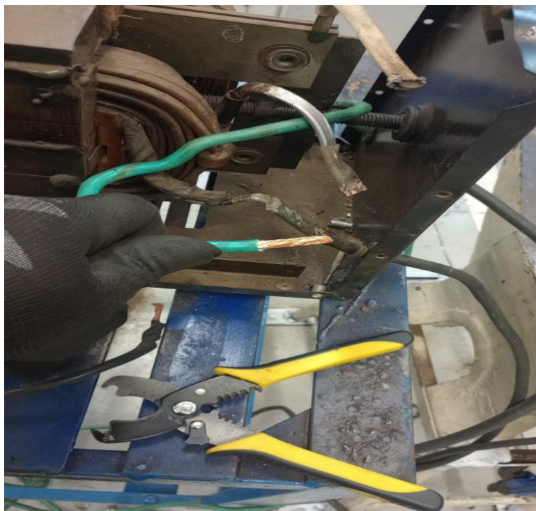
Figura 34: Troca dos cabos FONTE: Do próprio Autor, 2025
