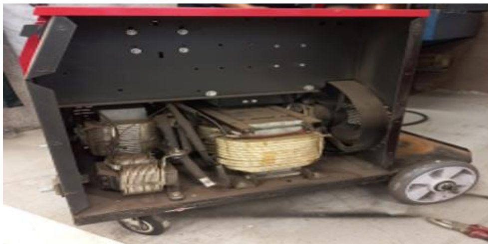
Figura 9: Máquina 1 sendo desmontada FONTE: Do próprio Autor, 2025
