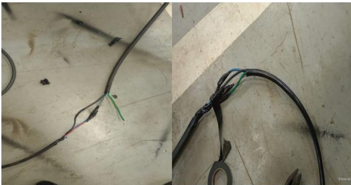
Figura 13: Realizado emendas no cabo de alimentação FONTE: Do próprio Autor, 2025
