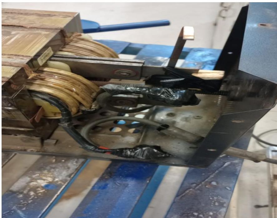
Figura 28: Troca dos cabos, e emendas com conectores FONTE: Do próprio Autor, 2025
