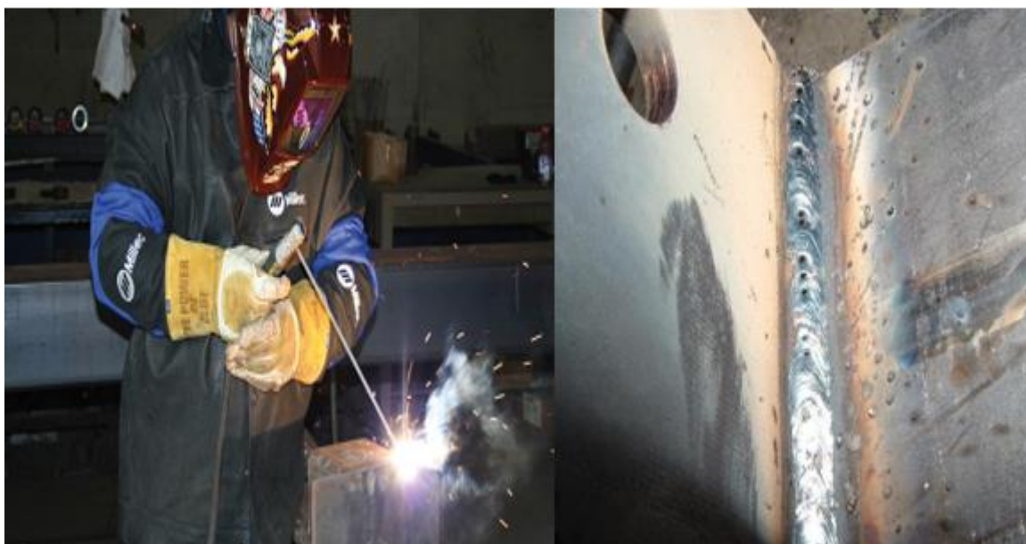
Figura 5: Solda Padrão ao Eletrodo Revestido
