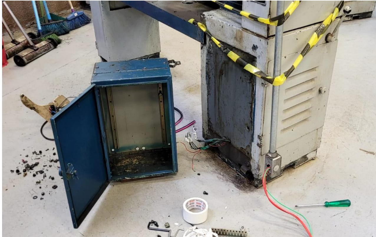
Figura: Retirada do painel antigo
