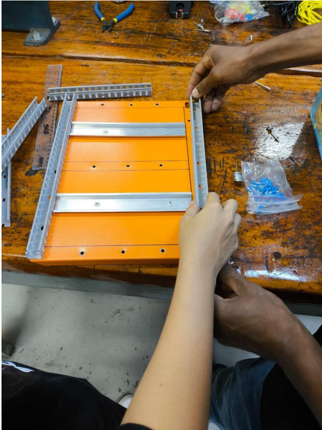
Figura: Fixação dos trilhos e canaletas
