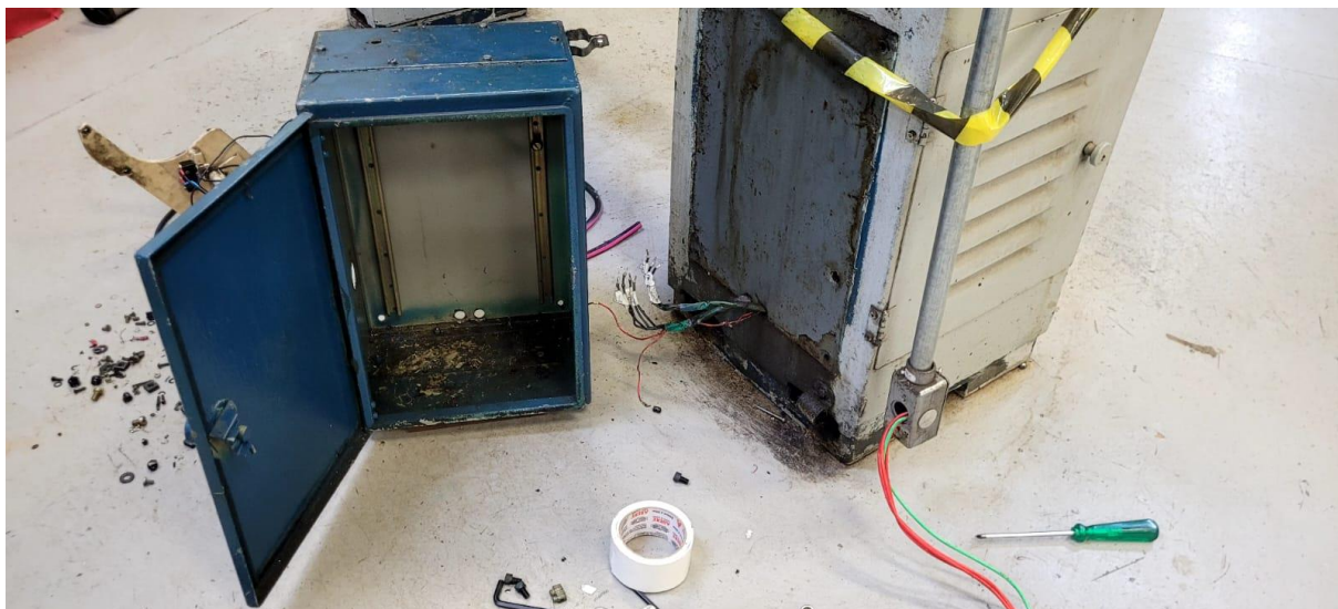
Figura 11: Retirada do painel antigo FONTE: Próprio autor, 2025
