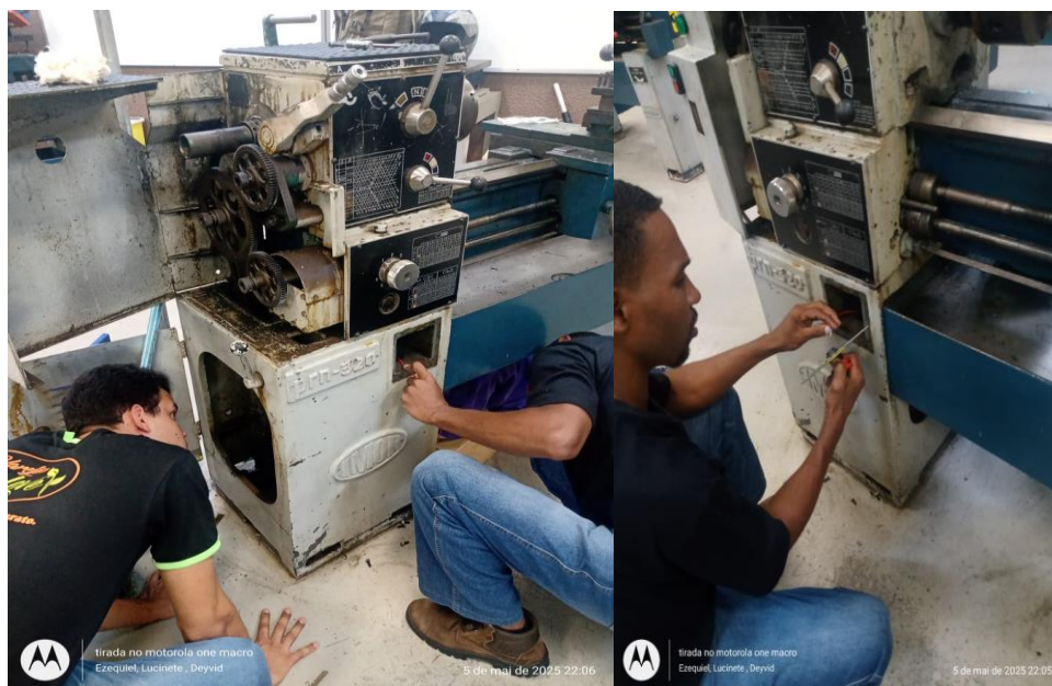
Figura 28: Passagem dos cabos e ligação do botão de emergência.
