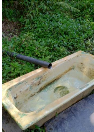
Figura 3 – Captação de água Nascente
