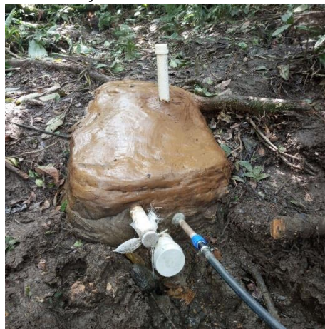
Figura 2 – Proteção de nascente método Caxambu
