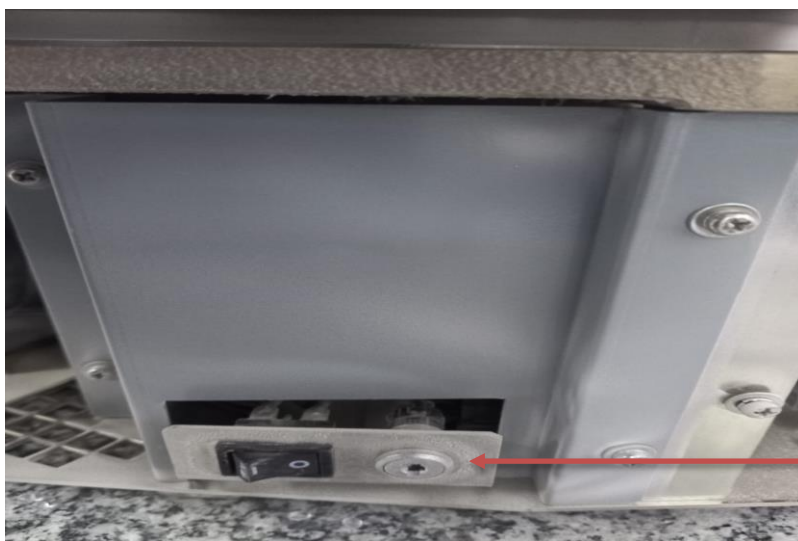
Figura 32 - Instalação do conjunto de chave.
