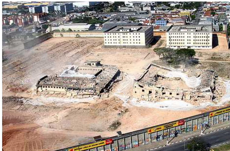
Figura 11 - Demolição parcial do Complexo Carandiru. Fonte: Prefeitura de São Paulo
