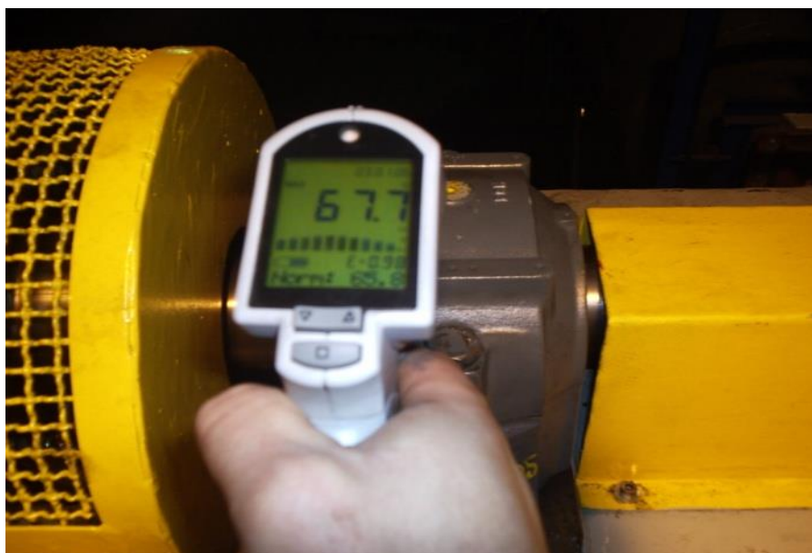
Figura 6 Imagem da medição de temperatura de um mancal com aparelho infravermelho. (Do autor).
