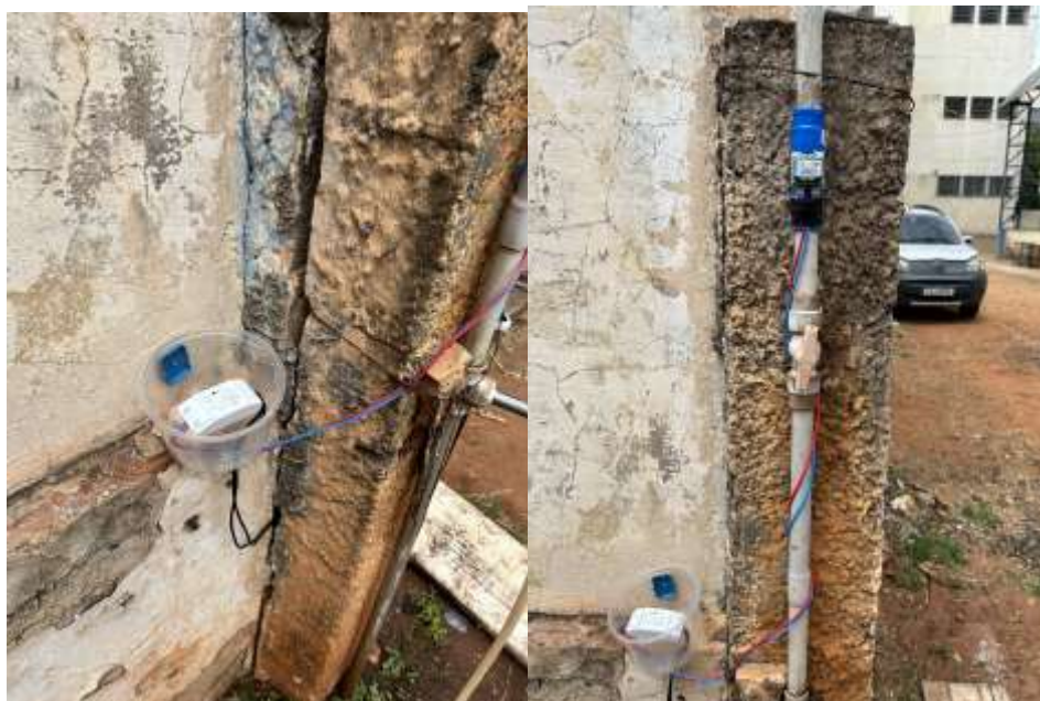
Figura 11 - Fotografia da Conexão da Válvula com o Relé
