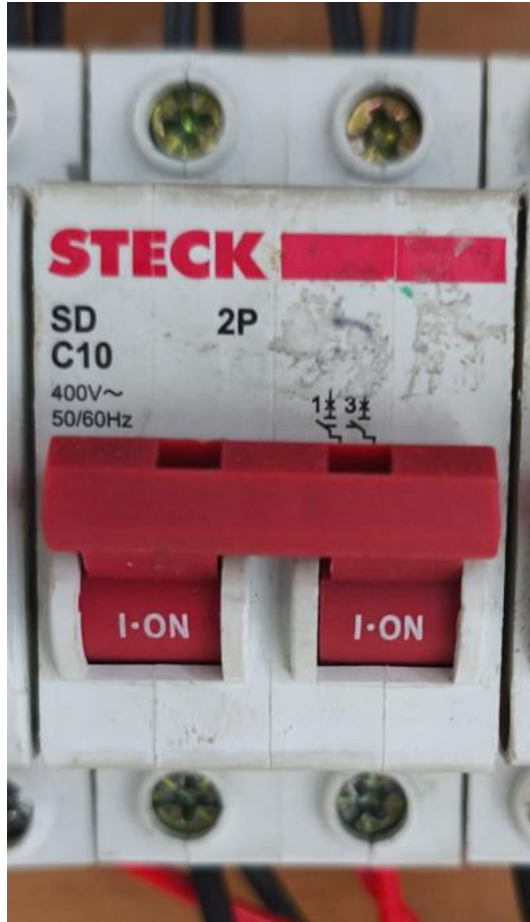
Figura 5: Disjuntor bipolar 10 amperes
