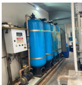
Figura 4: Tanques onde é tratado o efluente (MD Folheados, 2025)
