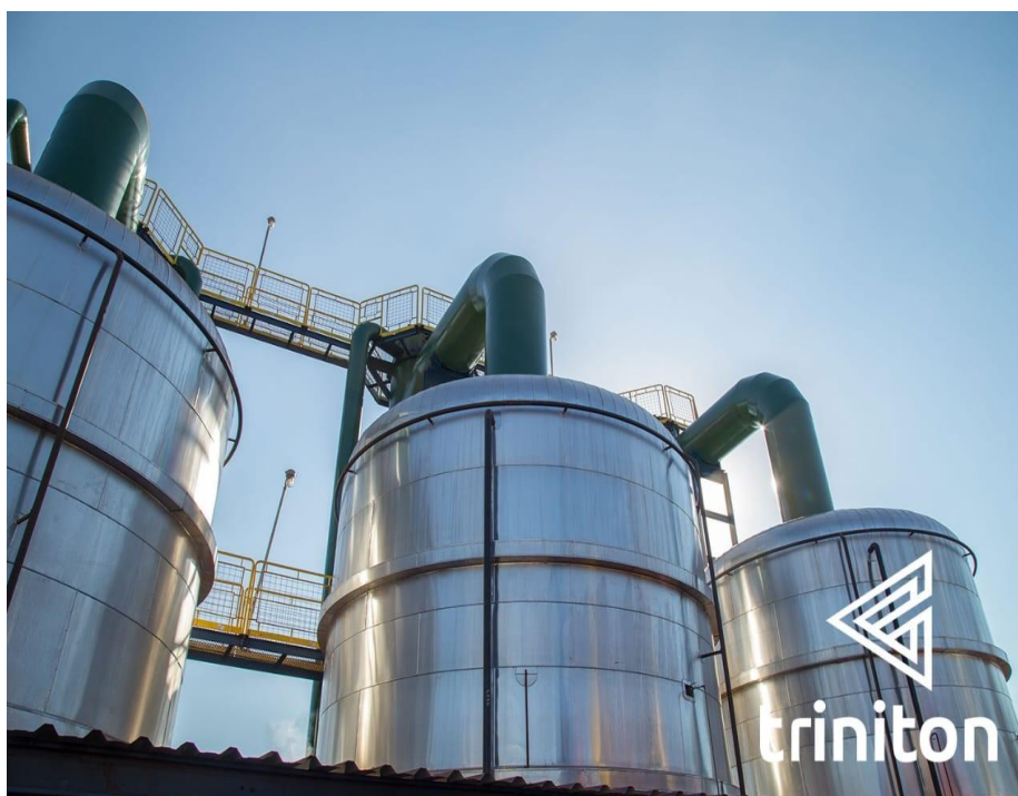
Figura 12 – Cozedor a vácuo
