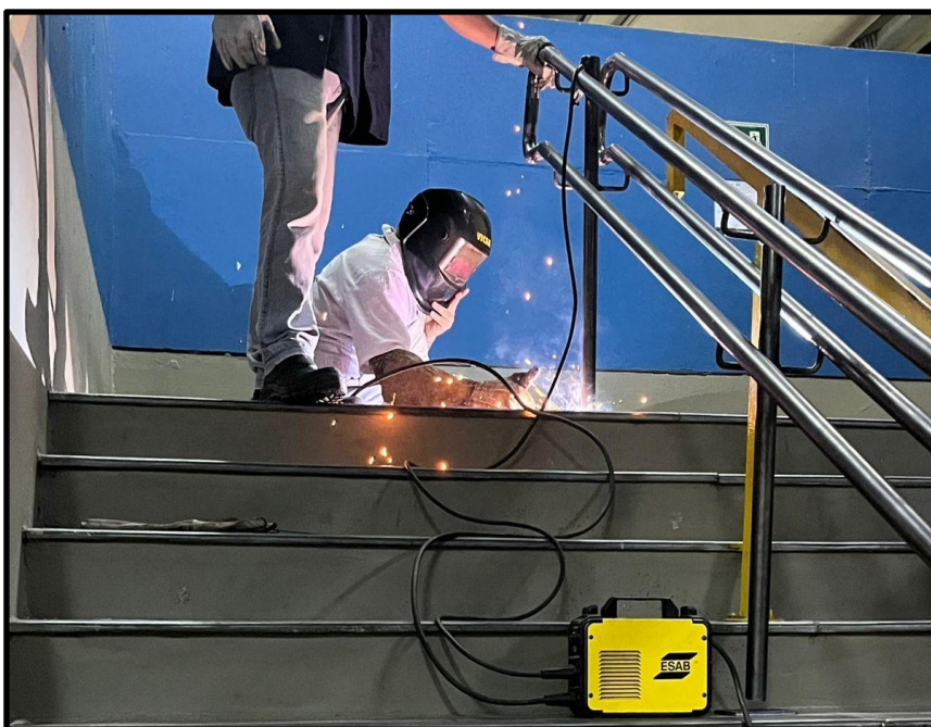
Figura 10 – Soldagem dos montantes nas chapas de base.
