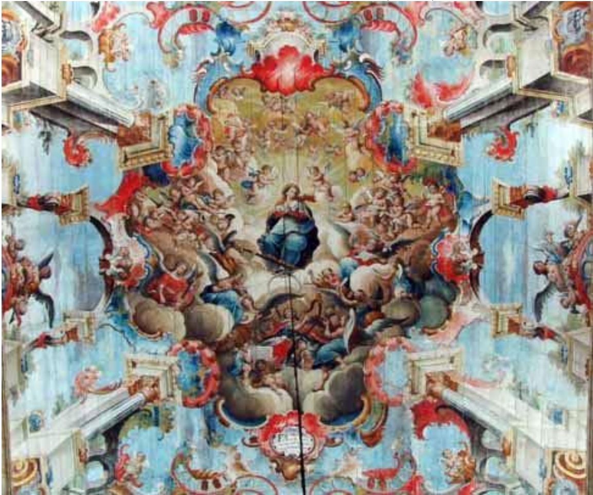
FIGURA 14 – IGREJA DE SÃO FRANCISCO DE ASSIS, TETO, COM PINTURA ATAÍDE
