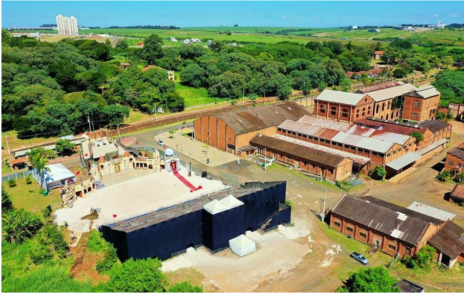
Figura 14: Imagem aérea diurna da Usina Santa Bárbara
