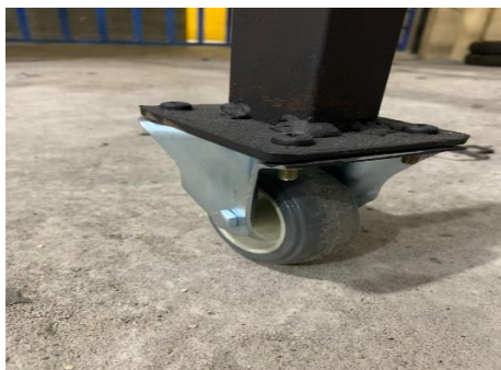
Figura 6 – Instalação de roldanas base do varal.
