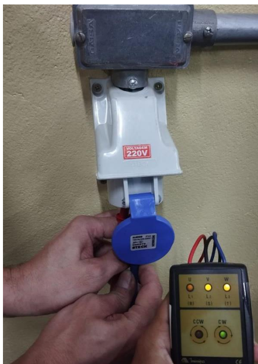
Figura: 36 - Verificação da sequência de fases do ponto trifásico e tomada da máquina de ensaio de tração.
