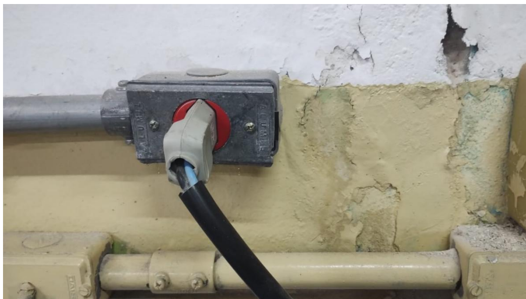
Figura: 13 - Ponto de tomada e conector subdimensionado para atender o forno 8000W
