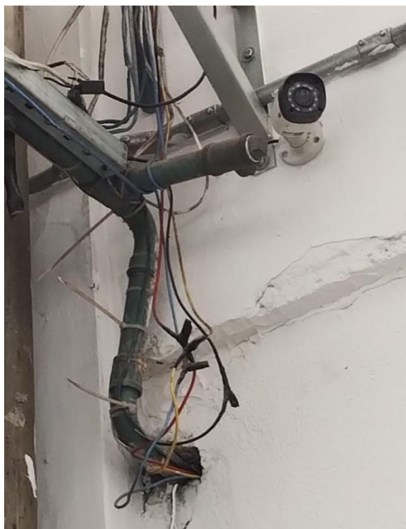
Figura: 8 - Cabos de alimentação elétrica entrando no laboratório através no laboratório de furo na parede
