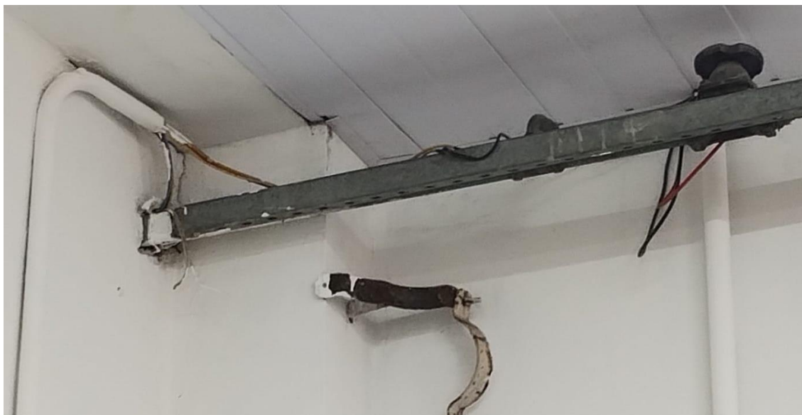
Figura: 7 - Cabos de alimentação elétrica chegando através no laboratório de furo na parede
