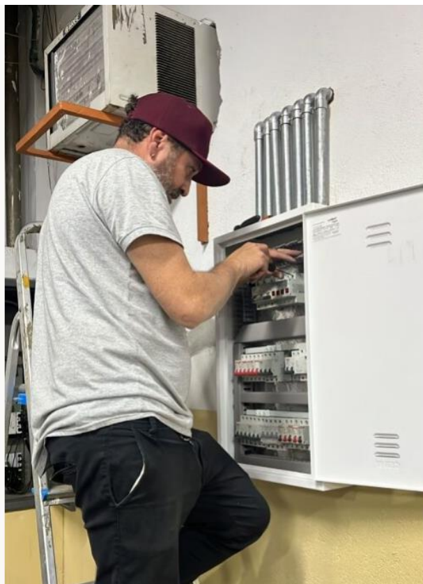
Figura: 30 - Finalização da montagem do painel elétrico e eletrodutos de saída.
