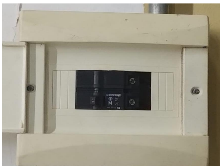
Figura: 12 - Painelelétrico existente para atender o Forno 8000W (Subdimensionado)
