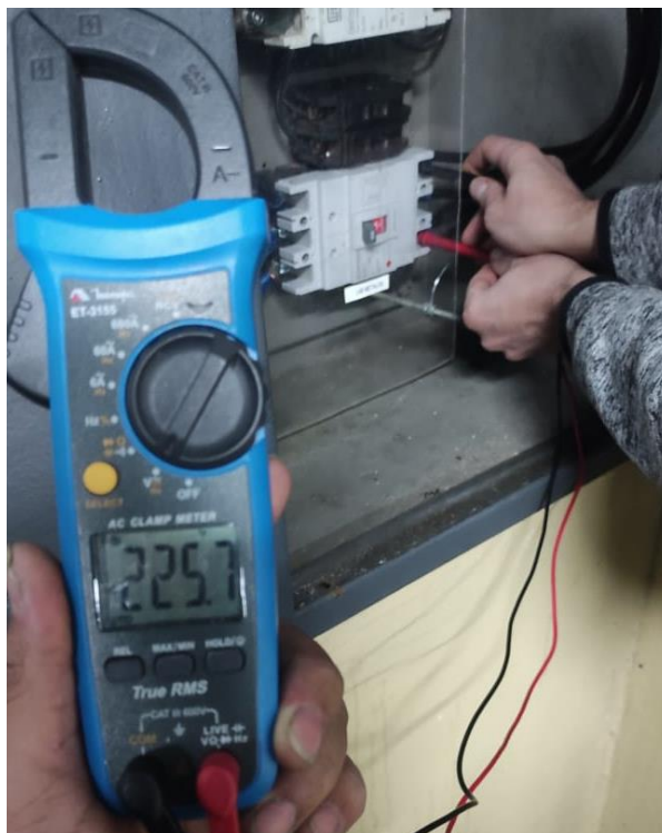
Figura: 40 - Medição da tensão elétrica no disjuntor caixa moldada instalado no QGBT da oficina mecânica, que fornece alimentação elétrica o quadro do laboratório de metalografia
