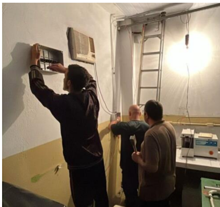
Figura: 31 - Desmontagem da infraestrutura elétrica antiga e início da montagem de nova infraestrutura
