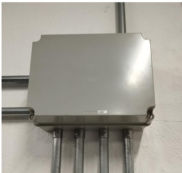
Figura: 34 - Detalhe da caixa de passagem para distribuição dos circuitos elétricos no laboratório
