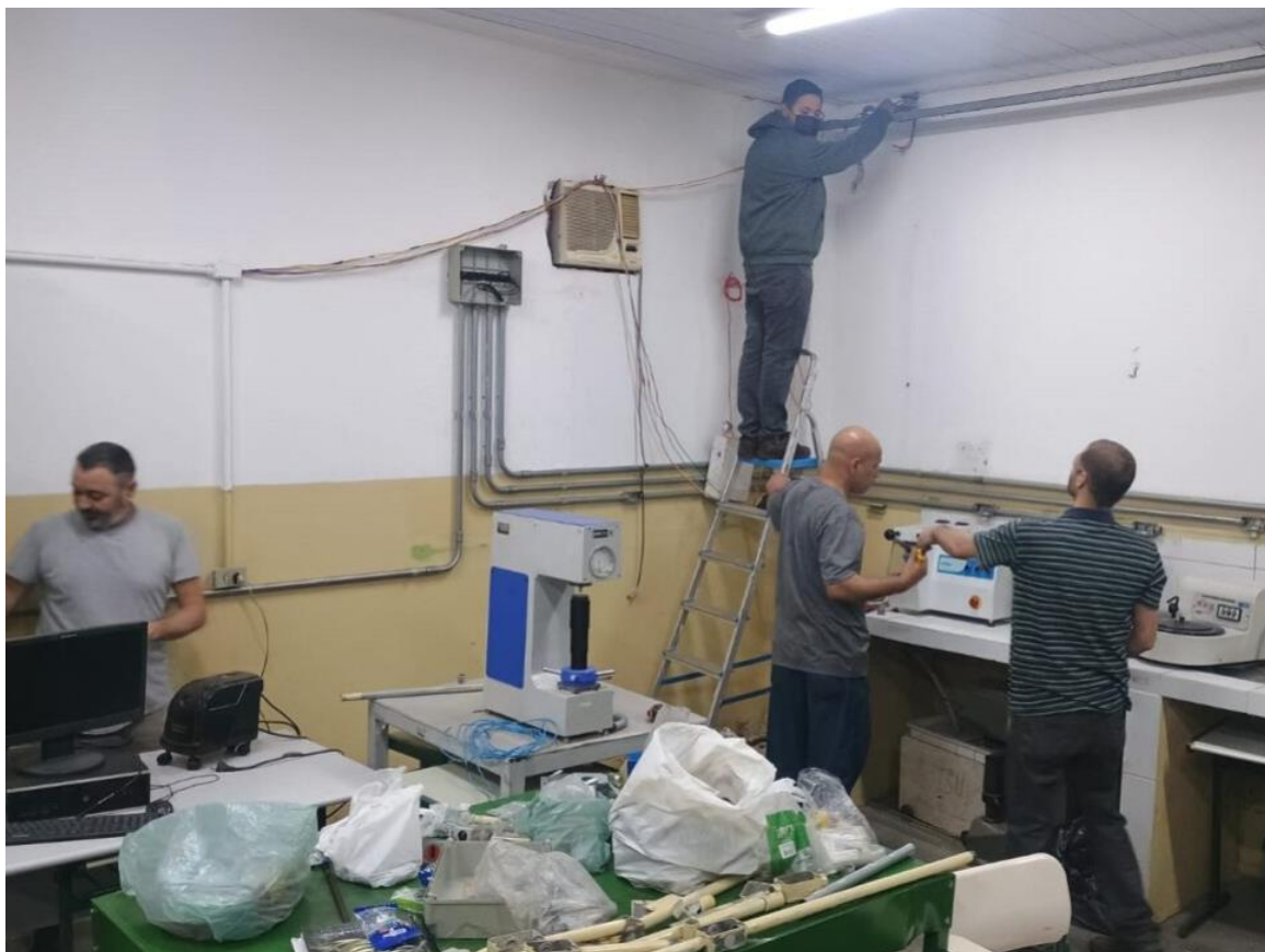
Figura: 32 - Instalação da nova infraestrutura de eletrodutos no laboratório
