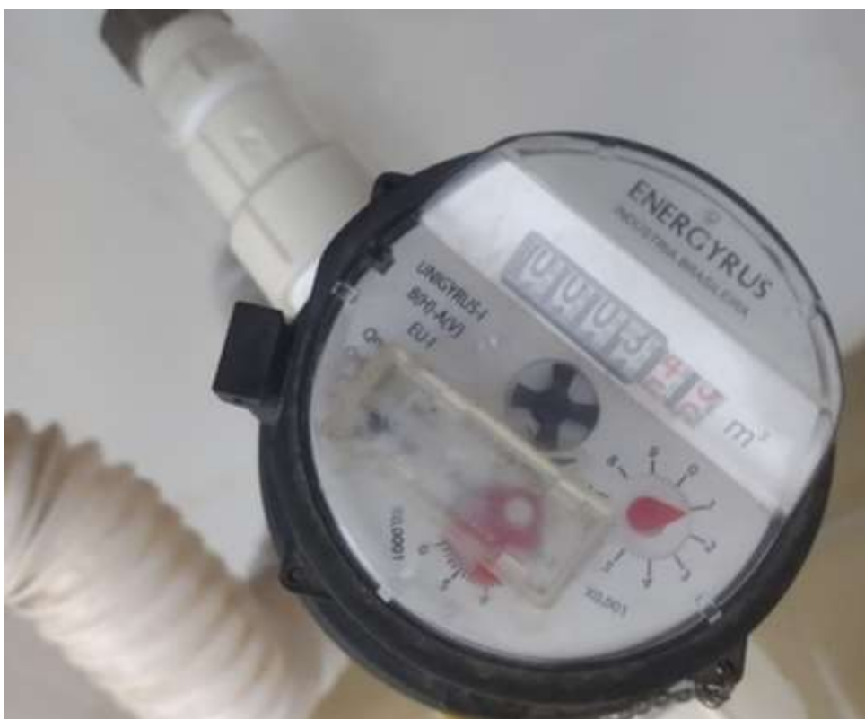
Foto 7 - Hidrômetro instalado na Estação de lavagem - fonte: própria
