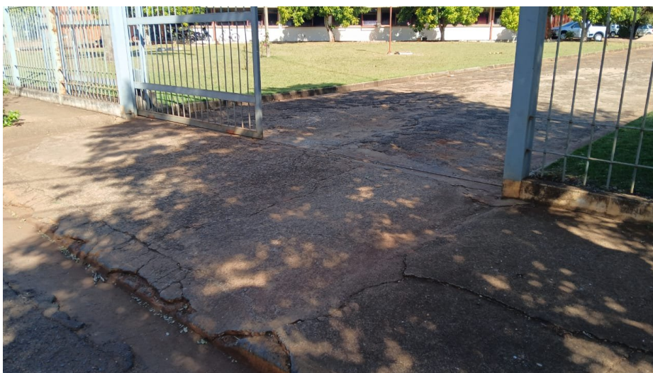
Figura 3 – Rampa deteriorada no Fórum da Comarca de Palmital - SP, Av. Reginalda Leão, 1500.
