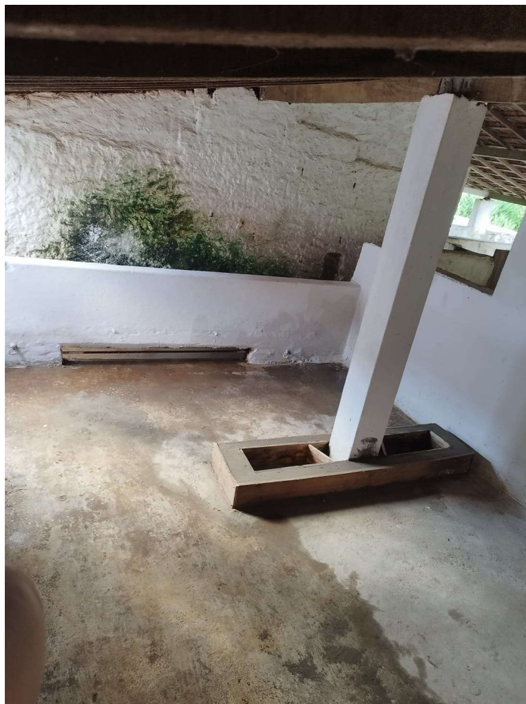
Figura 5- Término da obra Fonte: Henrique Trapp Stein (2024).
