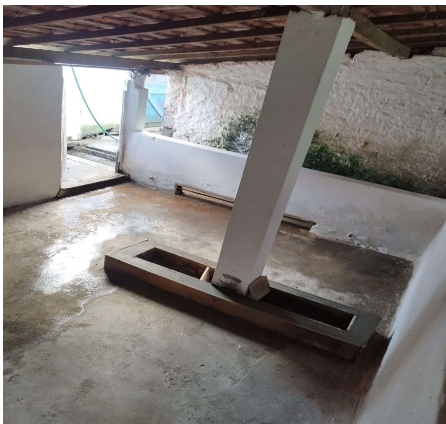
Figura 4- Após instalação do cocho Fonte: Henrique Trapp Stein (2024).
