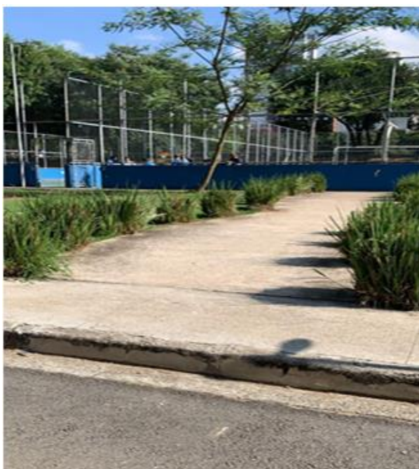
Imagem 1 – Acessos às quadras sem piso podotátil e calçada com rampa de acesso
