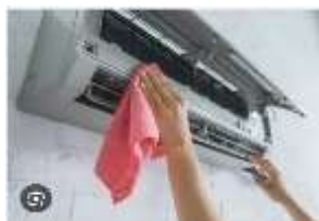
Figura 12.A- Limpeza externa do ar condicionado.
