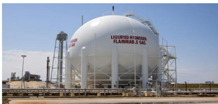
Figura 70 – Tanque de armazenamento do hidrogênio líquido
