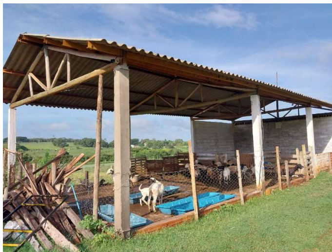
Figura 15 – Presença de entulhos na área
