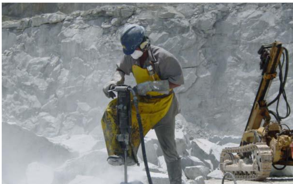
FIGURA 29 - Perfuração Secundária Realizada por Marteleiro Operando Perfuratriz Manual.
