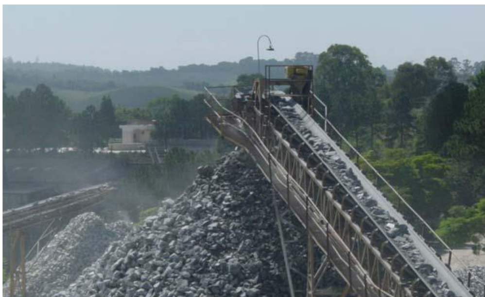
FIGURA 33 – Correia Transportadora do Britador
