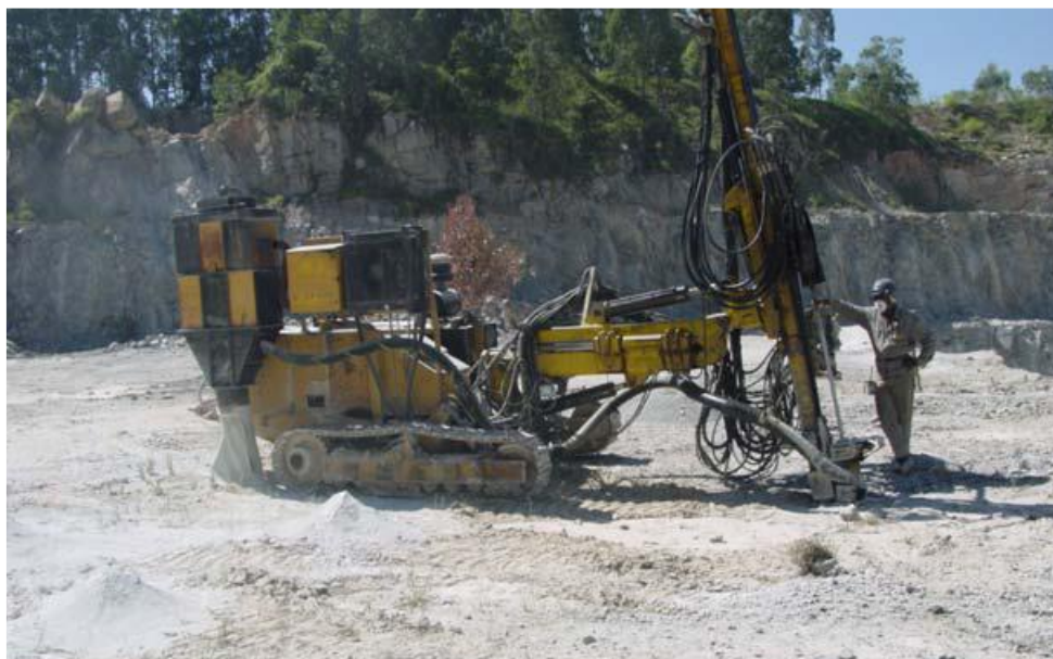
FIGURA 28 – Carreta de Perfuração Hidráulica Provinda de Sistema de Ventilação
