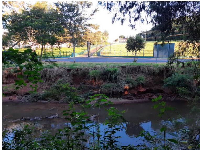
Figura 4 – Área com erosões em uma grande extensão do córrego falta de vegetação ou canalização
