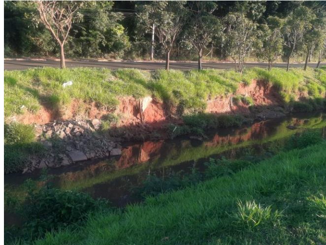
Figura 3 – Área com processo erosivo em estado avançado
