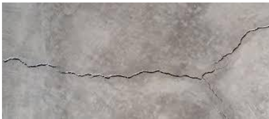
IMG. 1 – Fissuras provocadas por recalque do sistemas de pisos.
