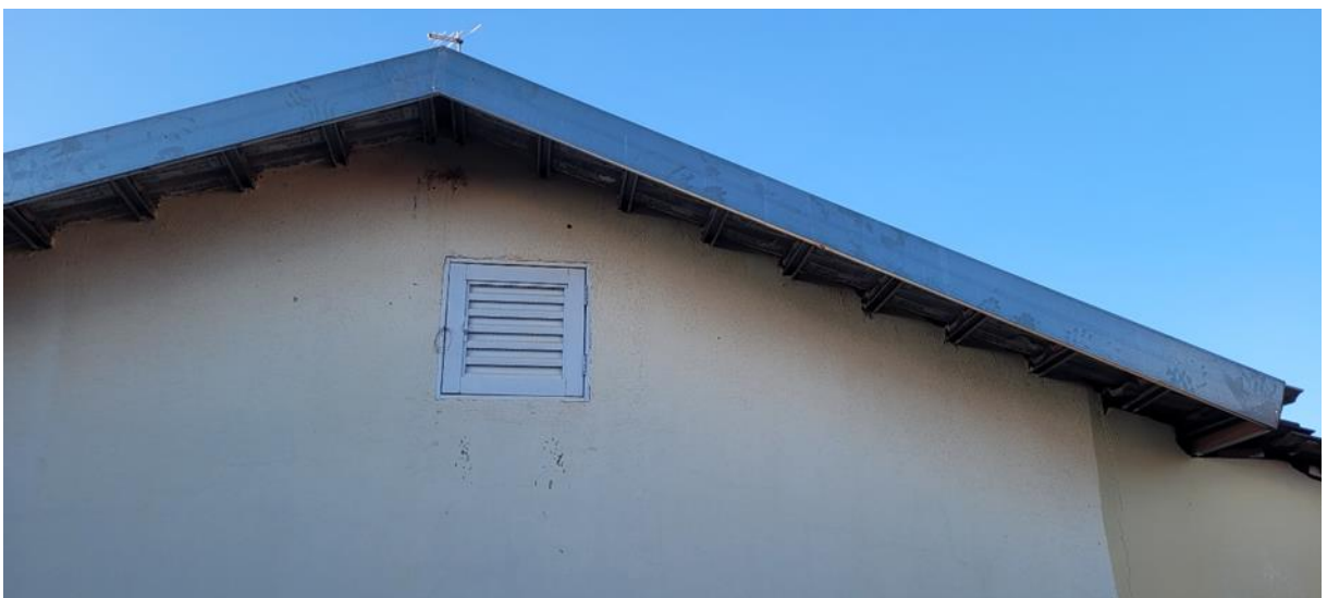
Figura 3 – Local onde será instalado reservatório superior
