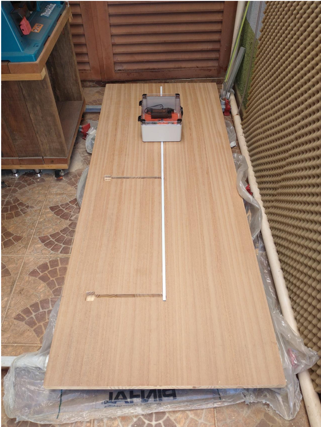
Figura 41 – Porta com quadro elétrico de comando e canaleta de PVC principal do circuito instalados.
