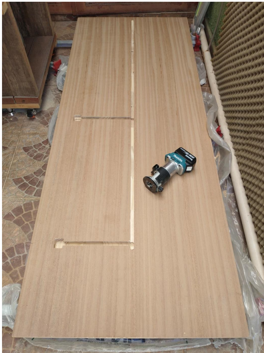
Figura 39 - Porta de madeira sólida e tupia laminadora – Mostrando processo de usinagem para instalação das canaletas de PVC, por onde serão passados os fios do circuito.
