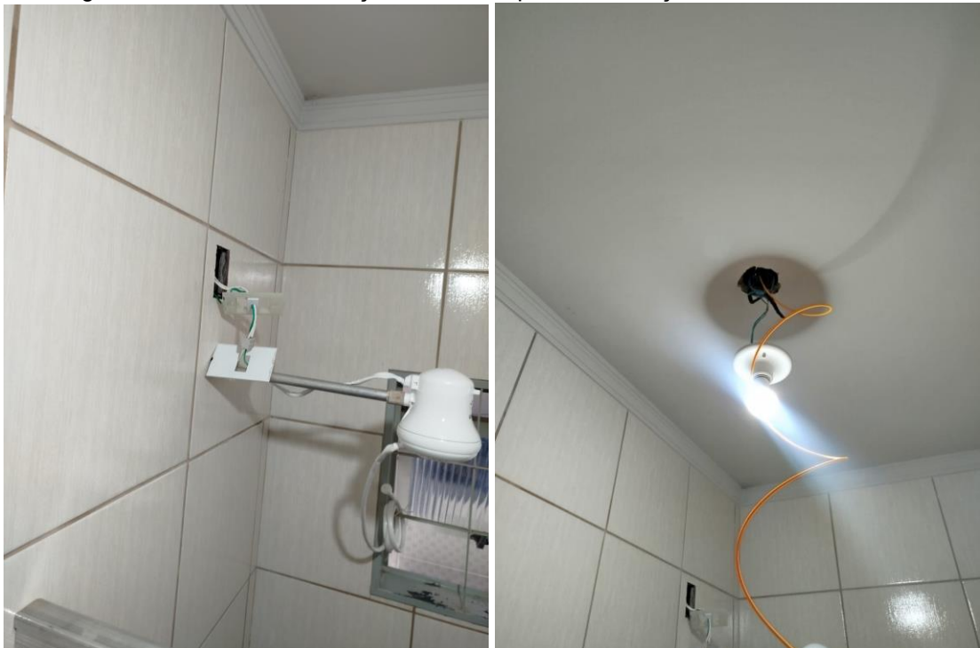
Imagem 23, 24, 25 e 26: Inserção dos cabos para alimentação de circuito e sensores.
