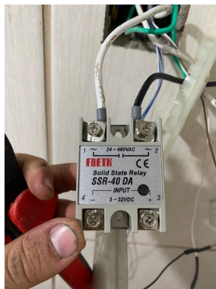
Imagem 21: Instalação de Relé de Estado Sólido.
