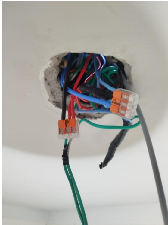
Imagem 22: Conexão de Fase + Neutro para alimentação da Fonte.
