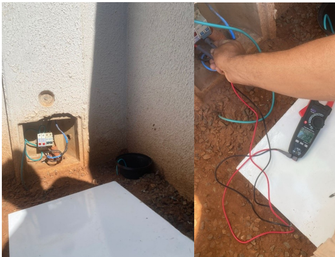
Figura 12: aterramento fizemos na residência
