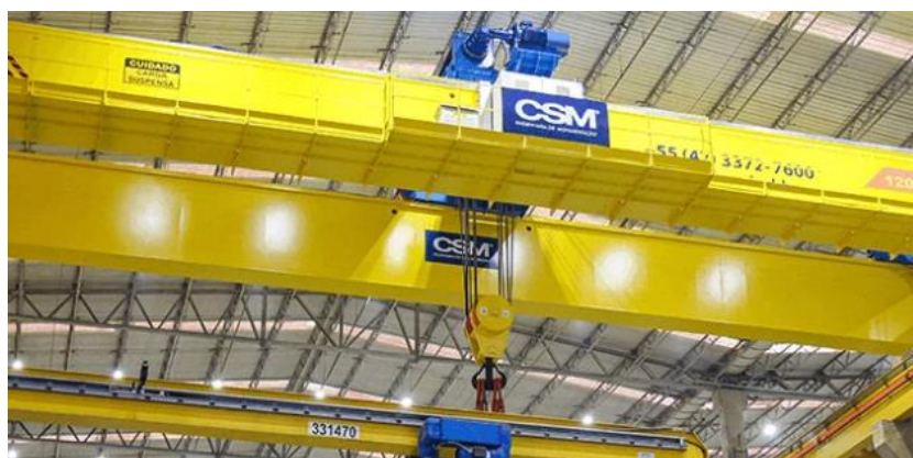
Figura 3: Componente da Ponte
