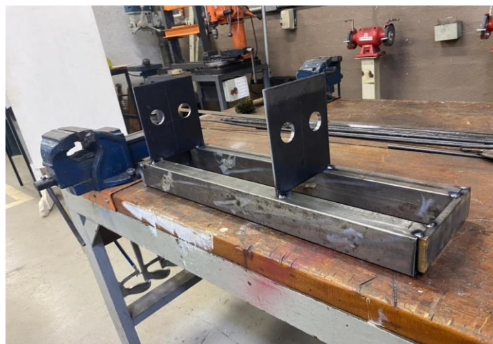
Figura 16: Chapas laterais soldadas na base
