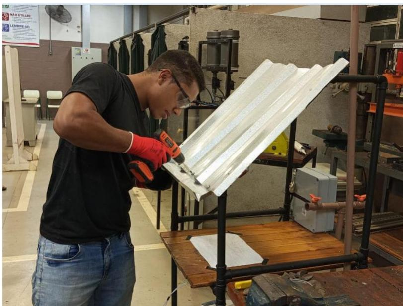
Figura 35 – Instalação de telhado com calha para captação
