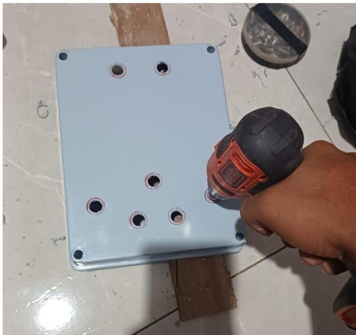
Figura 26 – Início montagem painel elétrico.
