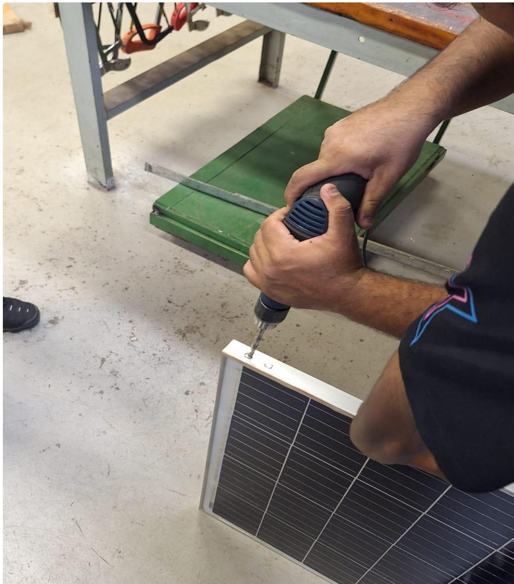
Figura 29 – Furos na placa Solar
