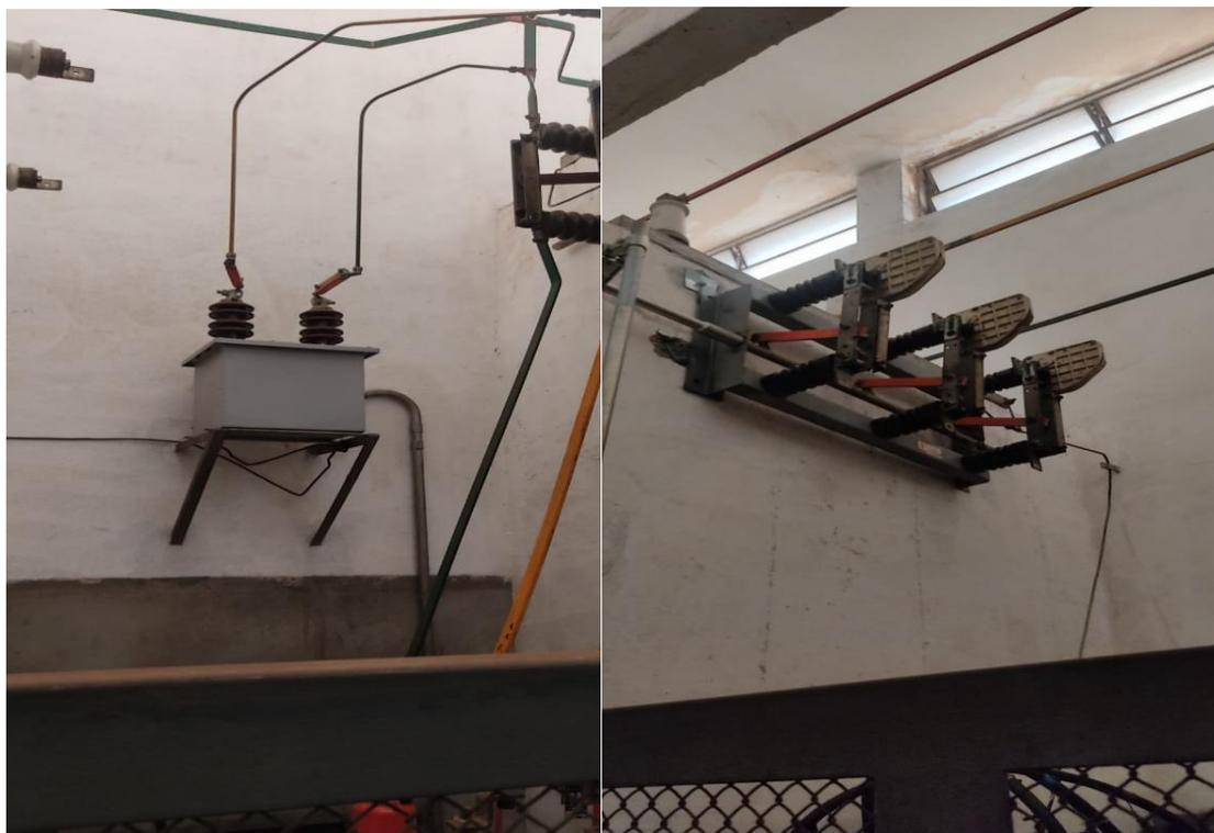
Figura 15: Transformador de potência (TP) a esquerda e chaves seccionadora tipo faca a direita.
