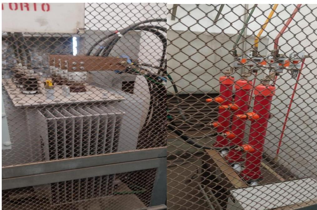
Figura 17: Vista lateral do Transformador a esquerda e disjuntor de media a óleo a direita.
