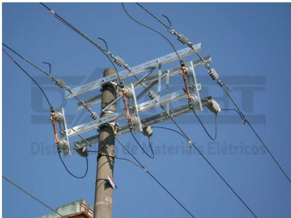
Figura 1: Chave Seccionadora Tipo Faca Unipolar
