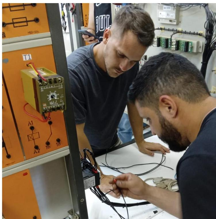
Figura 19 – Conexão dos cabos ao contator
