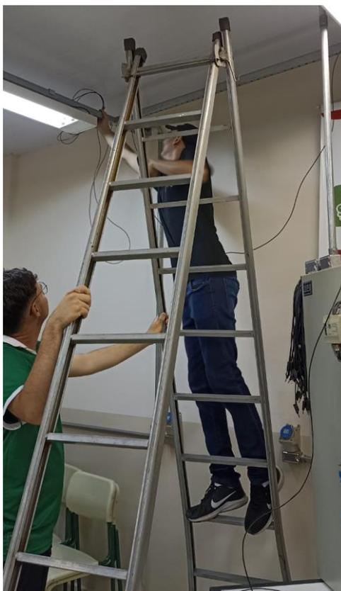
Figura 16 – Colaboradores passando cabos pelo perfilado
