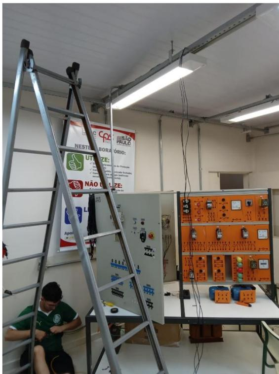
Figura 17 – Passagem de cabos
