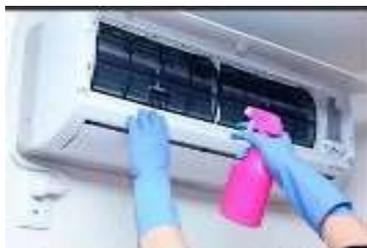
Figura 10 C. Filtro do ar sujo e depois limpo.
